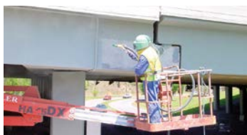
Puente Avenida del Estatut – Ronda de Dalt (Barcelona). Preparación del soporte: chorreo de arena.
