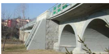
Puente en Masies de Voltregà (Barcelona). Productos utilizados: Mapegrout T40, Elastocolor Pittura.
