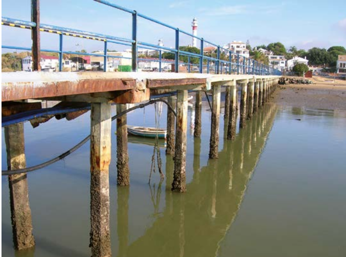
El antes y el después de la reparación del Pantalán en el Puerto de El Rompido (Huelva) Productos utilizados: MapeWrap Primer 1, MapeWrap 31, MapeWrap C UNI-AX, Mapelastic.
